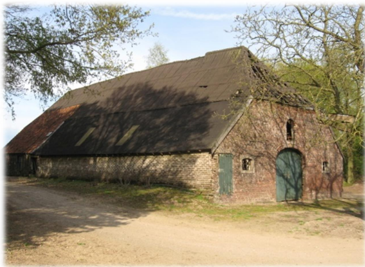
Toegang tot schuur en stallen (achterzijde)
